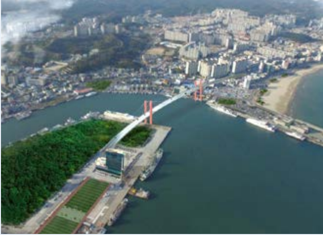
국지도 20호선 동빈내항 횡단교량 설치
