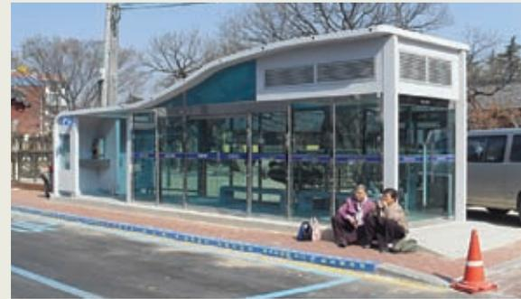
냉·난방기와 공중전화, 자동문이 설치된 다기능 시내버스 정류소가 등장했다. 포항시는 4월 7일 북구 흥해읍 영일민속박물관 앞 버스정류소를 다기능 시내버스 시범정류소로 설치했다. 정류소 규모는 길이 10m, 높이 2.5m, 폭 2.6m이며, 버스 타는 쪽에 자동문을 설치했다. 정류소 외벽은 강화유리 재질로 특수제작됐다. 이는 지난해 11월 1일부터 시행된 시내버스 노선개편 및 무료환승제 시행에 따른 이용객들의 편의와 대기승객들에게 쾌적하고 안락한 공간을 제공하기 위한 후속조치이다.
