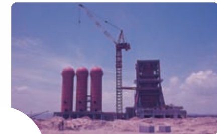
· 포스코 건립직전에 있었던 예수성심시년회(1967) · 제1고로가 완공 직전 (1972)
