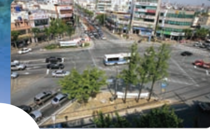
· 오거리전경 (1968) · 오늘날 오거리 전경 (2009)
